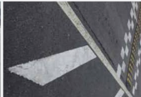
Longitudinal crack
